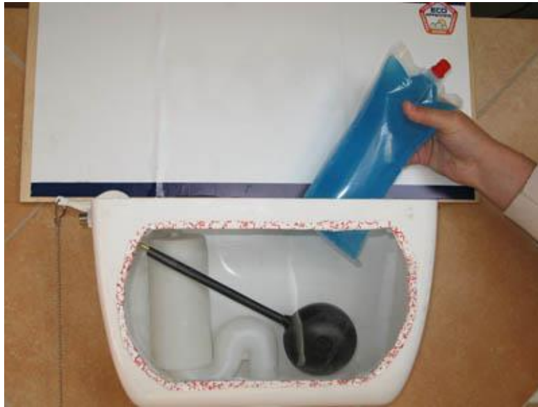
Installazione del sacchetto in una cassetta esterna
